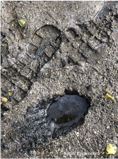
Figur 5. Bilde fra Kystverkets befarings i Nordre Sandvika 20. mars 2019. Bildet viser tråkk hvor olje piper opp.
