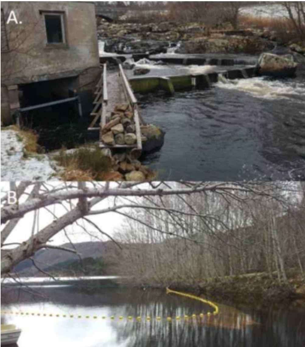
Figur 68. A) PIT-antenne vises som svarte rør montert på henholdsvis Kvernhuset (til venstre) og åpning i betongterskel (til høyre). Loggestasjonen er plassert inne i kvernhuset og er operative hele året. B) Elveruse for fangst av utvandrende fisk i utløpet av Vatnevatnet. (Fra Berntsen mfl. 2019b, bilder Marius Berg)
